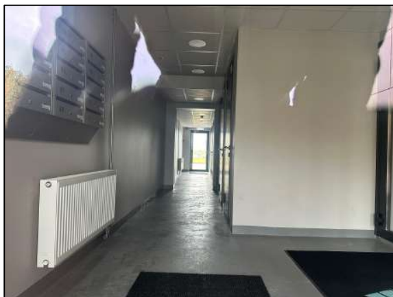
Attēls Nr. 5: Iekšskats trepju telpā
